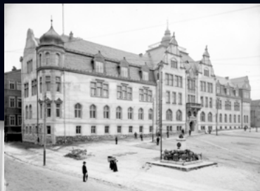
Bau des Hauptgebäudes der Bergakademie: Bauarbeiten am Neubau des unteren Teils vom rechten Flügel und des zentralen Teils im Jahr 1903.
